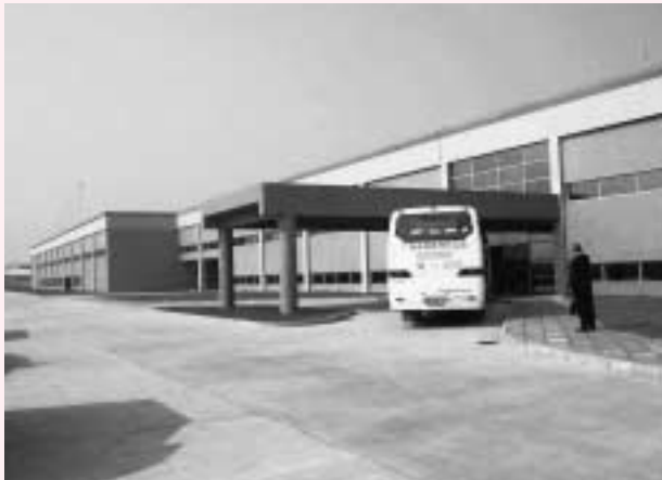
広々とした土地に建築許可申請から半年足らずで工場が完成した。従業員宿舎、食堂も同じ敷地内にある。
