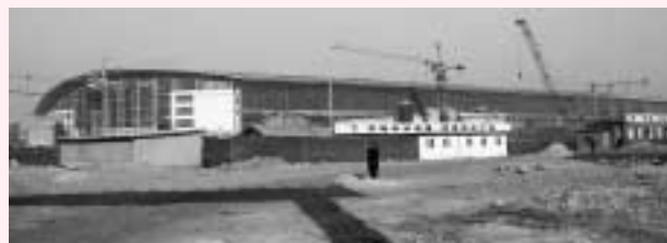
建設中の展示場。今年6月には完成の予定。
