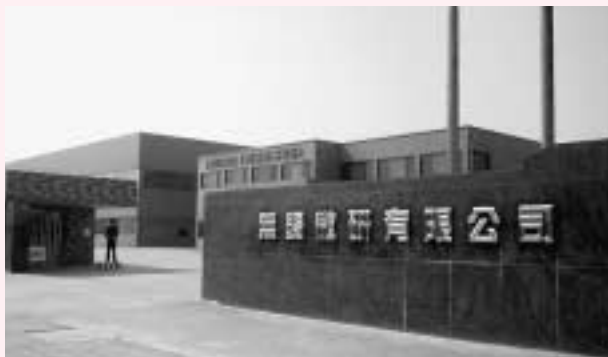
工場：現在、隣接地に新工場を建設中
