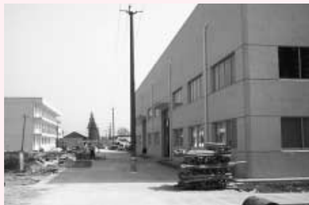
建設中の新工場
