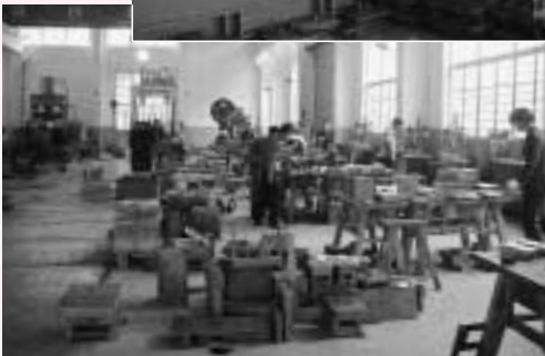
拡張工事中の 工場
