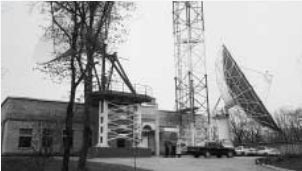
日本の技術が取り入れられた「ポストーク・テレコム」の通信施設
