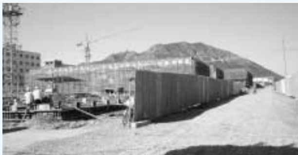
現在建設中の大連部品加工供給センター
